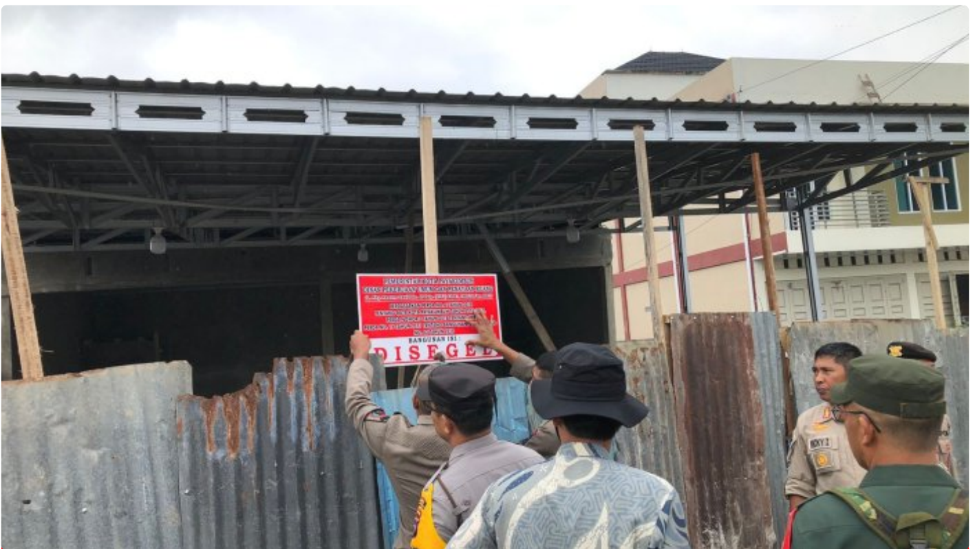
Menyalahi Aturan LP2B, Ada 5 Bangunan Disegel Dinas PUPR
